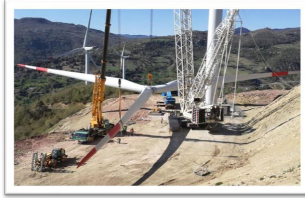
Şekil 5.49 Kanat Kurulumu
