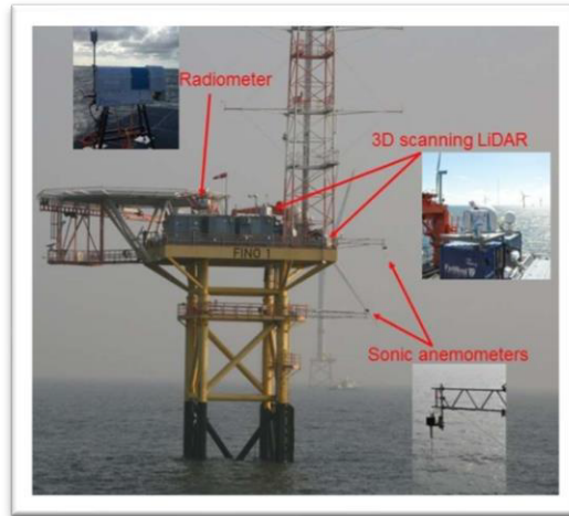
Şekil 13.2 Platform Üstü Lidar
