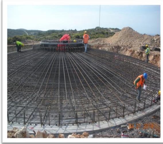
Şekil 6.10 Rüzgâr Türbini Temeli Demir İşlemleri
