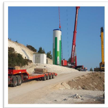
Şekil 6.38 Kule Montajı
