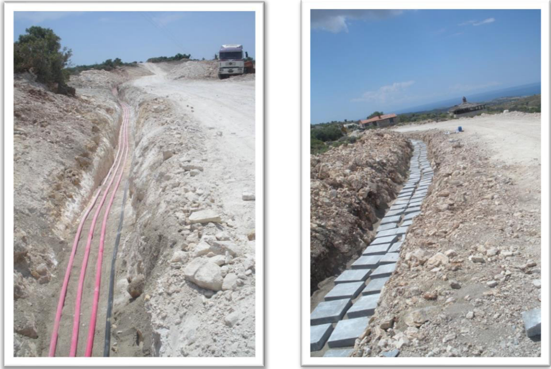
Şekil 6.16 Kablo Kanalı Yapımı
