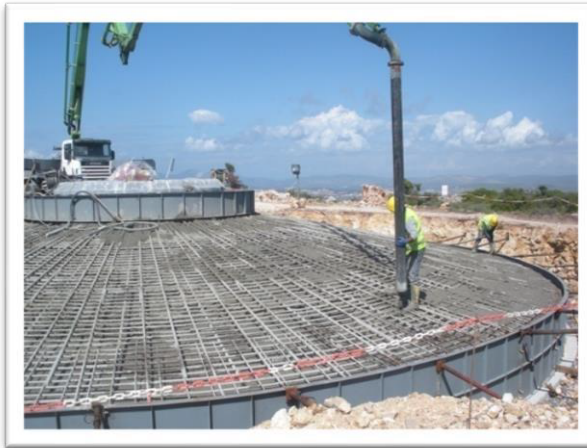
Şekil 6.11 Rüzgâr Türbini Temel Betonunun Dökümü
