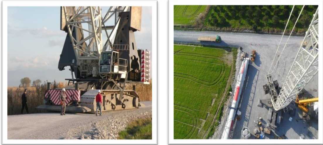
Şekil 6.17 Vinç Çalışma Sahasının Yapımı
