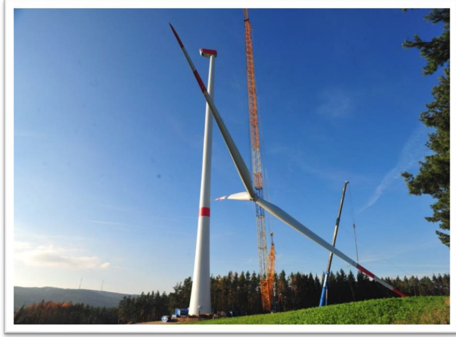
Şekil 6.41 Yıldız Montajı Gerçekleştirilen Bir Rüzgâr Türbini
