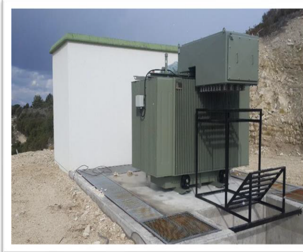
Şekil 6.42 Trafo Montajı
