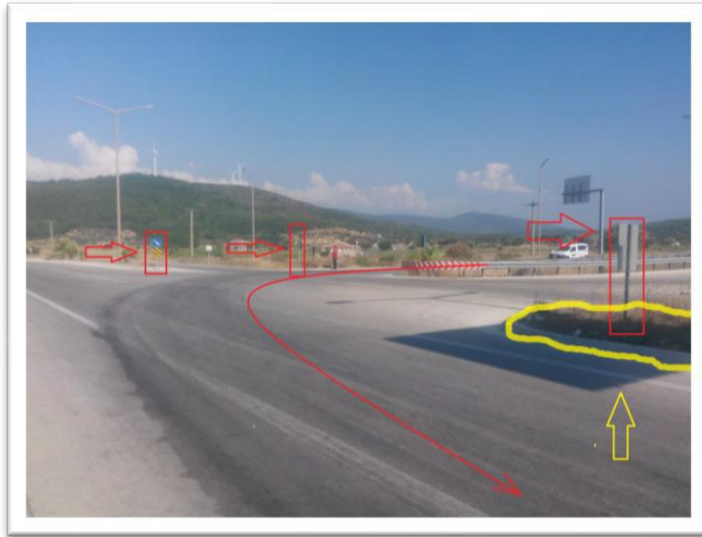
Şekil 6.23 Kaldırılması İstenen İşaretçiler
