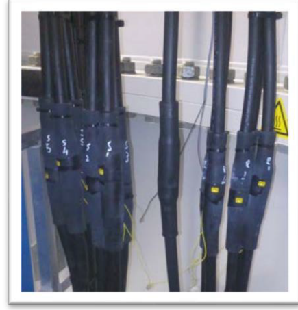
Şekil 7.6 Termal Kamera ile İnceleme İşlemleri
