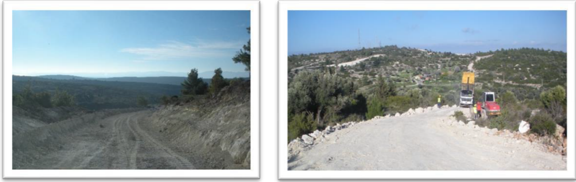
Şekil 6.2 Saha İçerisinde Yapılan Yol Çalışmaları
