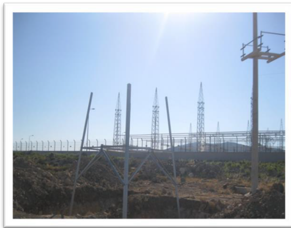
Şekil 6.43 Enerji Nakil Hattı Direklerinin Yerleştirilmesi
