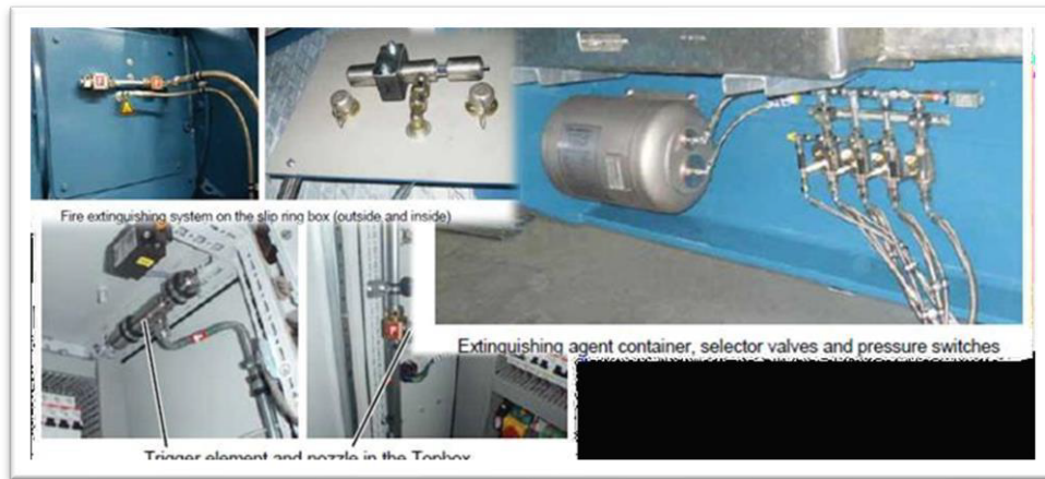
Şekil 5.41 Yangın Söndürme Sistemleri
