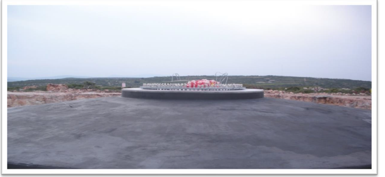
Şekil 6.12 Beton Dökümü Tamamlanmış Türbin Temeli
