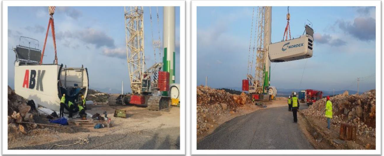
Şekil 6.39 Nasel Montajı
