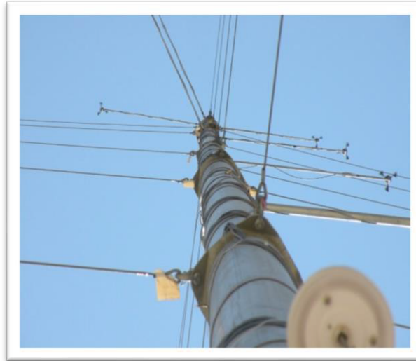
Şekil 2.16 Boru Tip Direk
