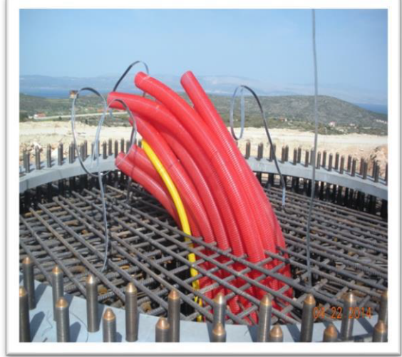
Şekil 6.10 Rüzgâr Türbini Temeli Demir İşlemleri
