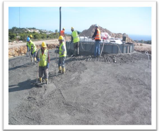
Şekil 6.11 Rüzgâr Türbini Temel Betonunun Dökümü
