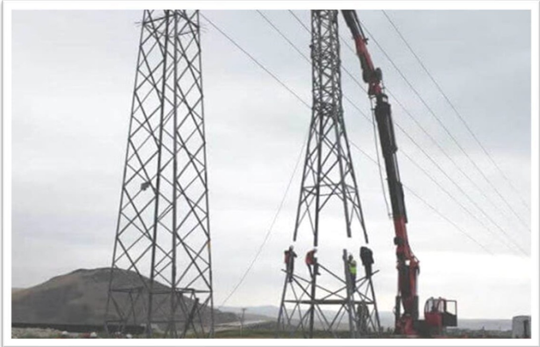
Şekil 6.45 ENH Direği Montajı
