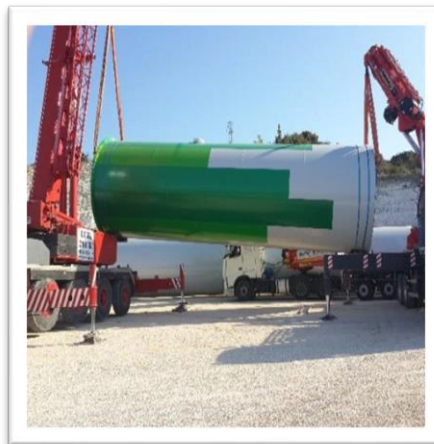
Şekil 6.38 Kule Montajı
