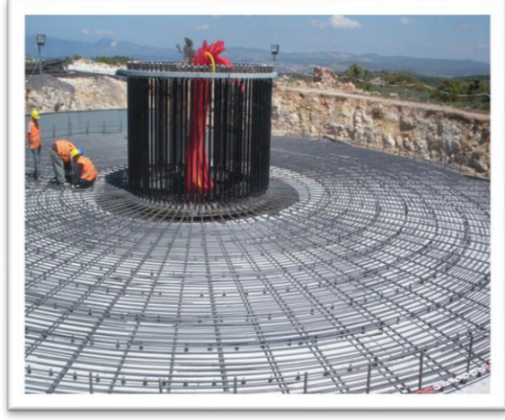
Şekil 6.9 Rüzgâr Türbini Taban Ankrajı
