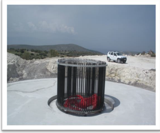
Şekil 6.9 Rüzgâr Türbini Taban Ankrajı
