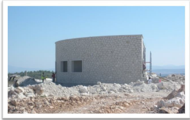
Şekil 6.14 Şalt ve Kontrol Binası İnşası
