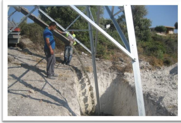
Şekil 6.44 Enerji Nakil Hattı Direklerinin Beton Dökülerek Sabitlenmesi
