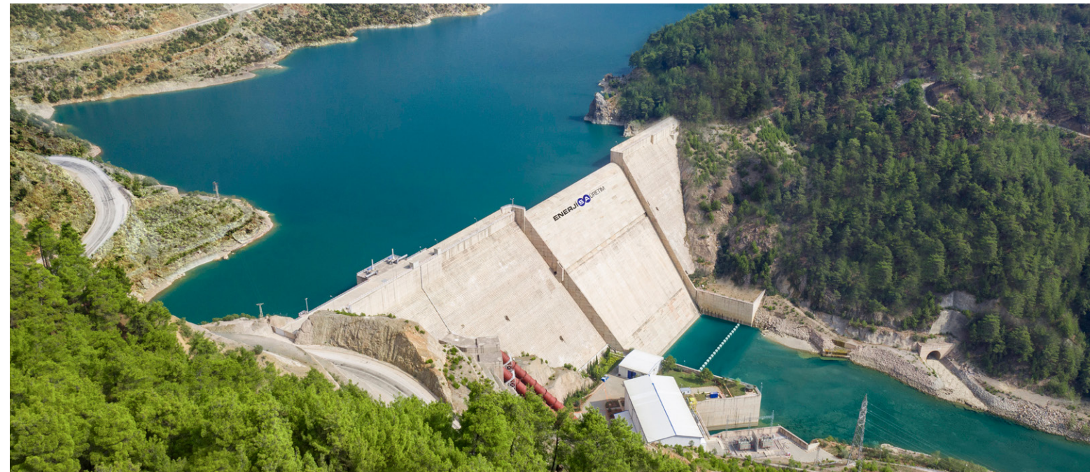
Köprü Hidroelektrik Santrali, Adana
